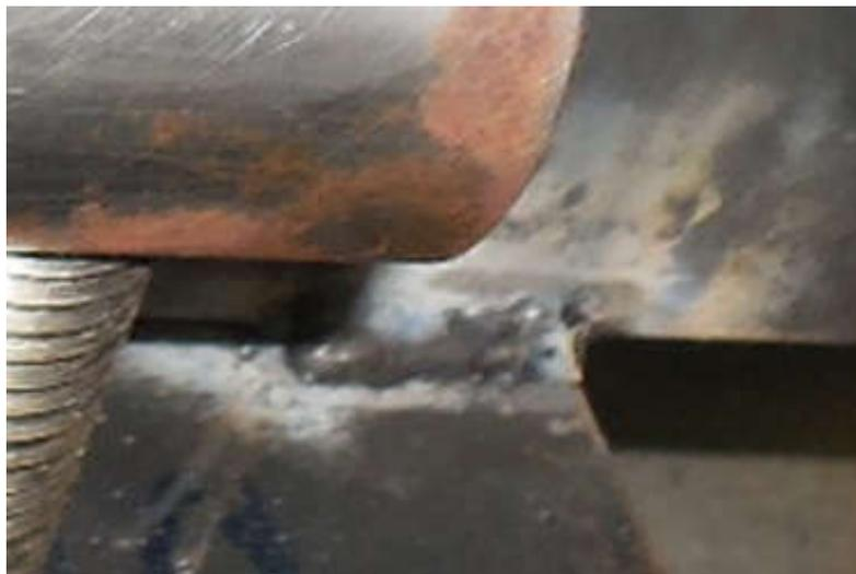
**Figura 39:** Solda da chapa inferior na viga transversal do quadro.
